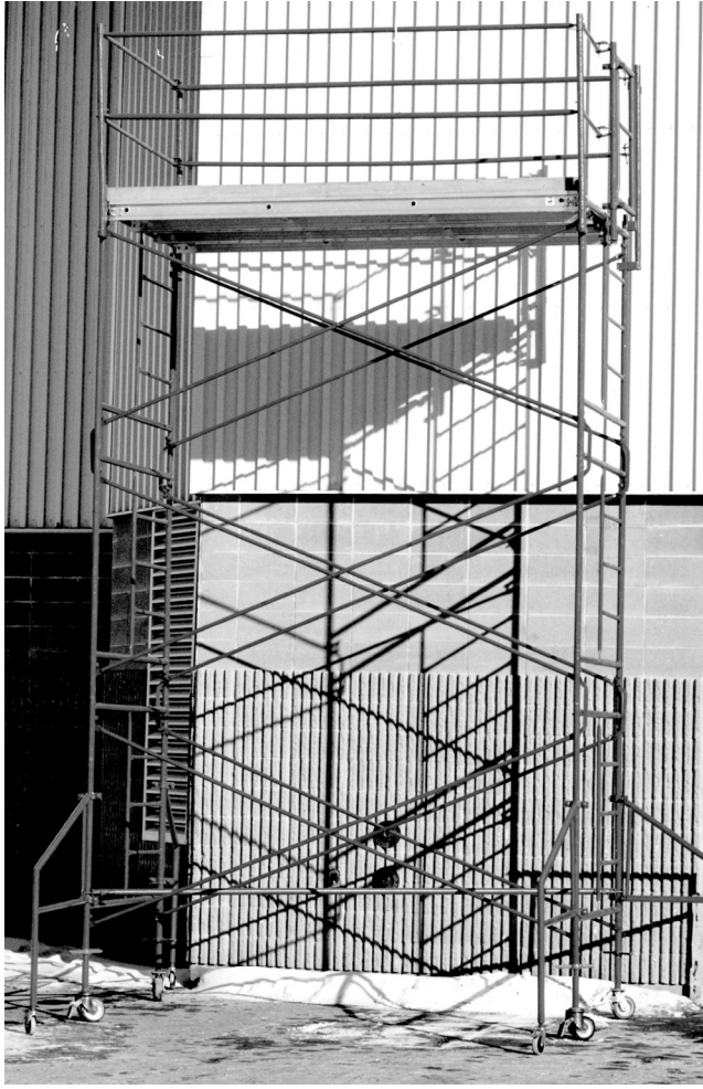
Échafaudages sur cadres montés sur roulettes
