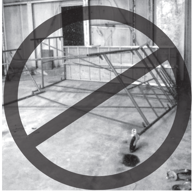
Renversement d'un échafaudage
