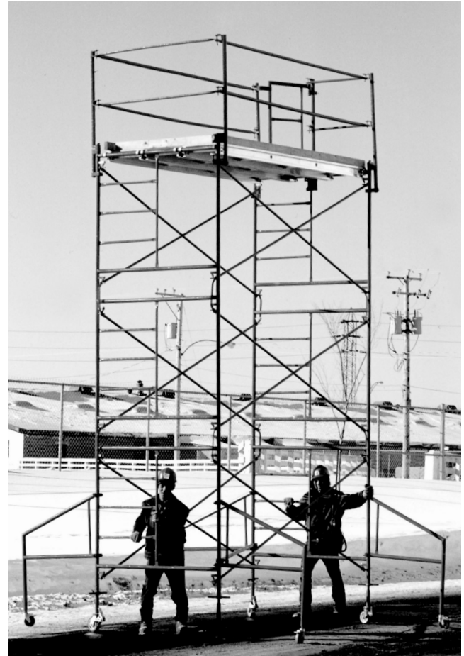
Avant de déplacer un échafaudage, il faut le décharger complètement.
