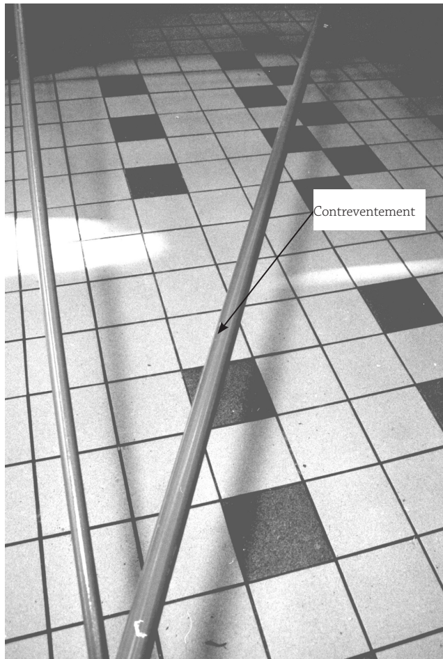
Dans le plan horizontal, le contreventement doit être fait tous les trois cadres de hauteur.
