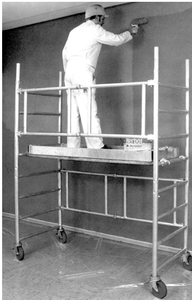
▲ Échafaudages mobiles conçus pour être roulants
