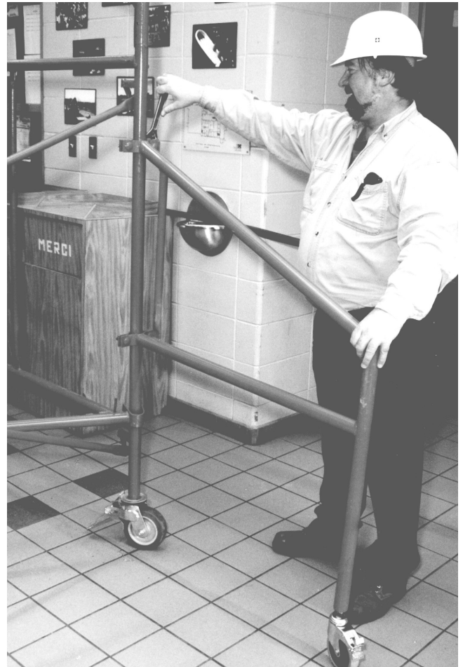
Lorsque la hauteur de l'échafaudage dépasse trois fois la plus petite dimension latérale de sa base, utiliser des stabilisateurs ou un système équivalent.
