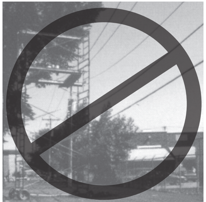
Échafaudage mobile situé à proximité d'une ligne électrique
