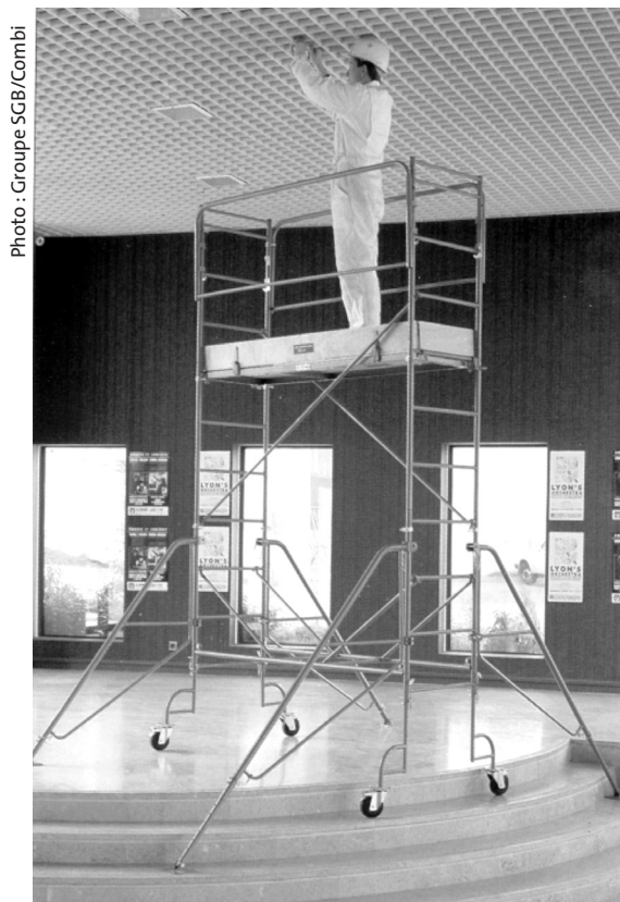
▲ Échafaudages mobiles conçus pour être roulants
