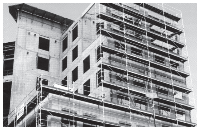
Échafaudage sur cadres métalliques européens
