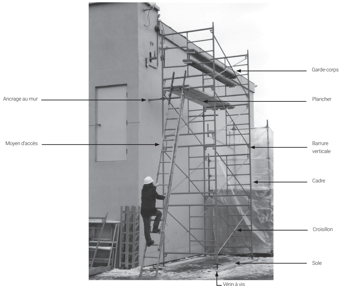
Composants des échafaudages sur cadres métalliques
