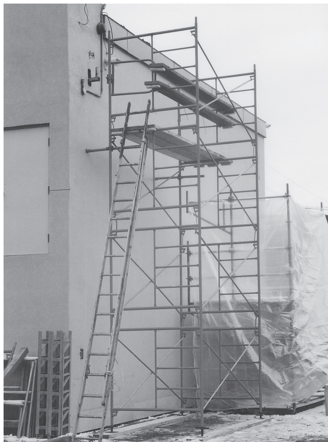
Échafaudage sur cadres métalliques traditionnels
