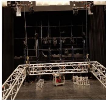
Avant la levée, une vérification visuelle des composantes ainsi qu'une vérification de la fonctionnalité et l'installation sont requises.
