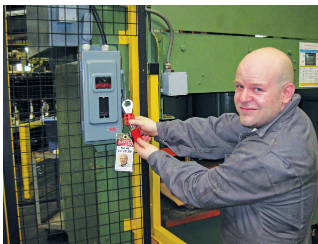
Cadenassage d'une installation électrique
